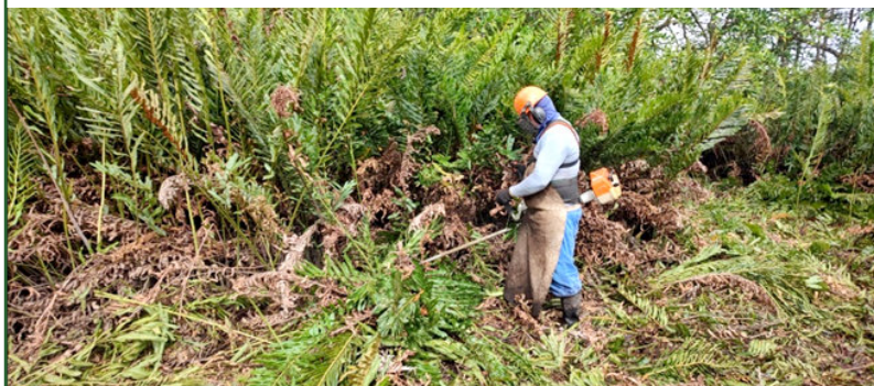
Figura 21 – Atividade de preparo de área (limpeza)
